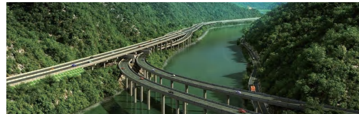
清西大桥项目
