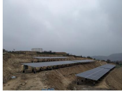
图注：在凉水河镇油坊沟村建设分布式光伏
