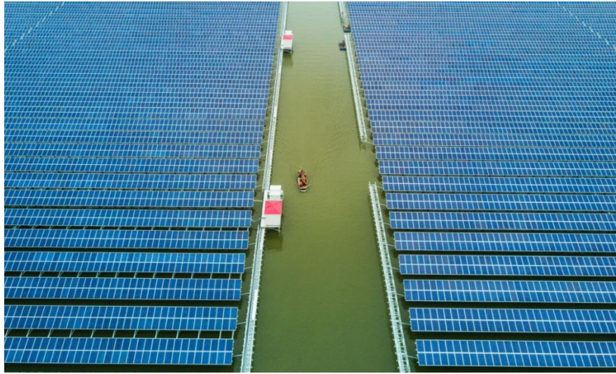
图注：中核汇能慈溪光伏项目
